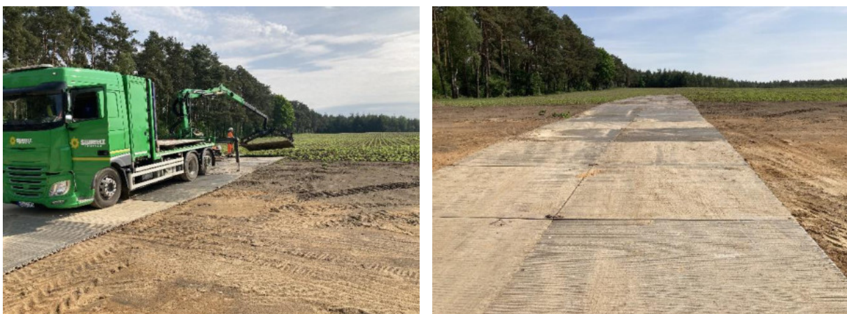
Abbildung 5: Beispiel für das Auslegen von Lastverteilungsplatten (Ingenieurbüro Linnemann)
